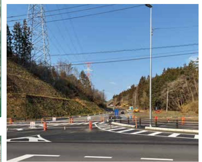
東側道路入口(施工中) 2026年開通予定
